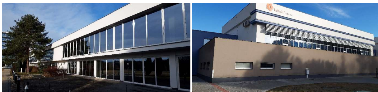
Obrázek 3: Krytá promenáda pro návštěvníky lázní a budova s krytým bazénem
