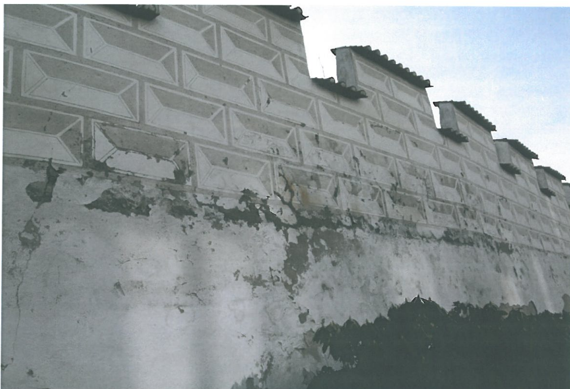
Detailní pohled na hlazenou omítku hradební zdi in situ dne 10.2.2011– celková degradace všech omítkových vrstev včetně barevné povrchové úpravy, viditelné silné zavlhčení
