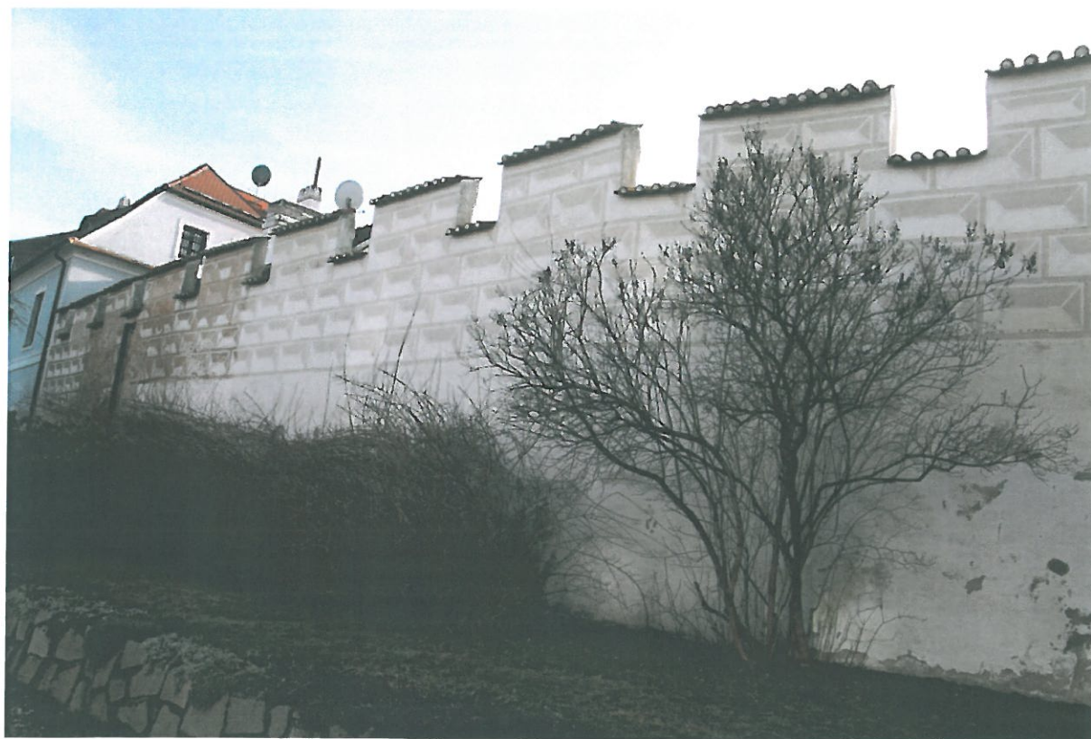
Celkový pohled na fasádu hradební zdi in situ dne 10.2.2011 – celkový pohled -silná degradace omítkových vrstev
