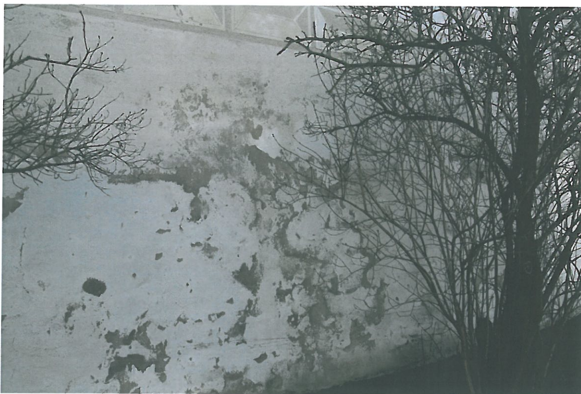
Detailní pohled na hlazenou omítku hradební zdi in situ dne 10.2.2011– celková degradace všech omítkových vrstev včetně barevné povrchové úpravy, viditelné silné zavlhčení
