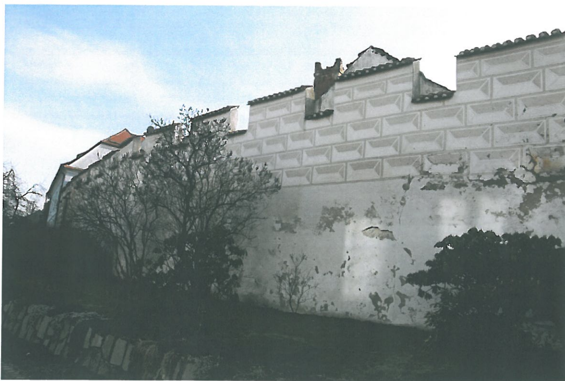
Celkový pohled na fasádu hradební zdi in situ dne 10.2.2011 – celkový pohled -silná degradace omítkových vrstev
