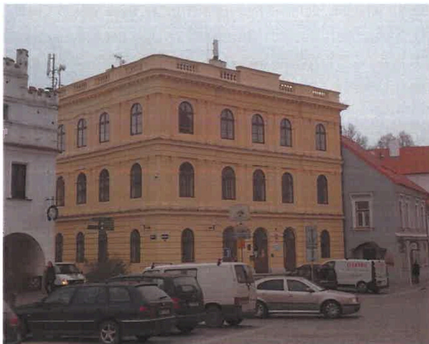
Obr. 3: Pohled na předmětnou budovu z Masarykova náměstí (detail jižní fasády)
