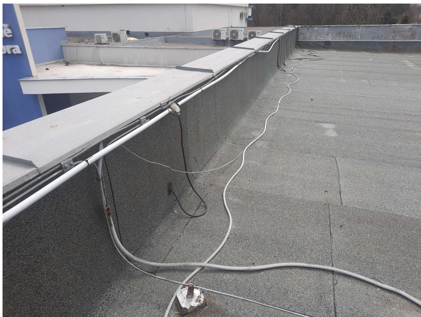
Obr. 6 – pohled na konstrukci atiky s prostupujícím kabelem
