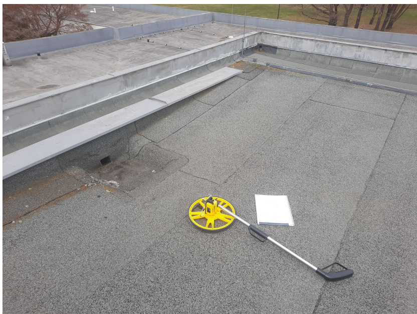
Obr. 2 – pohled na střešní chrlič strojovny a jedinou stranu atiky
