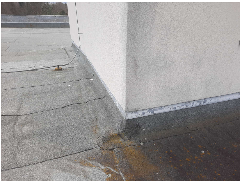
Obr. 4 – vytažení hydroizolační vrstvy na strojovnu
