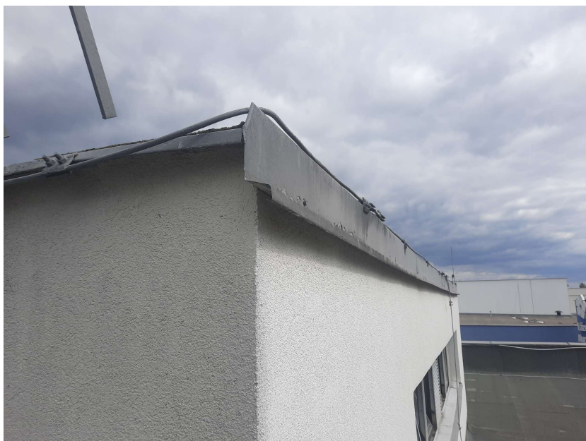
Obr. 3 – pohled na závětrnou lištu strojovny výtahu
