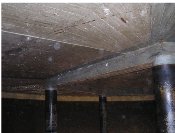
Obrázek 11: Pohled na strop. konstrukci se zesilujícími trámy
