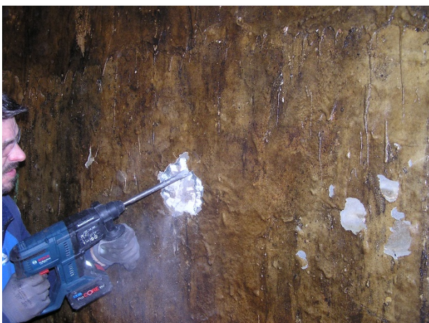
Obrázek 5: Odstranění cementové stěrky
