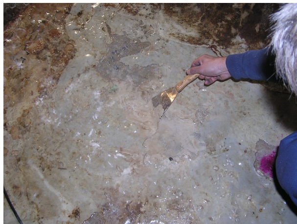
Obrázek 20: Minimální přídržnost epoxidového nátěru
