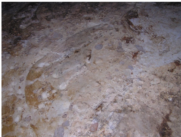
Obrázek 19: Pohled na oddělující se epoxidový nátěr dna
