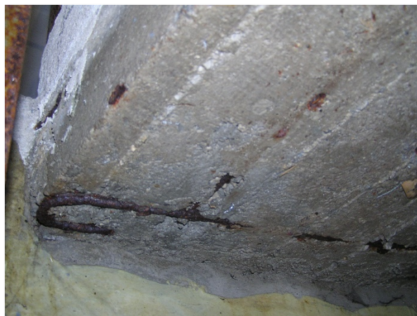
Obrázek 14: Značná koroze výztuže u vstupu
