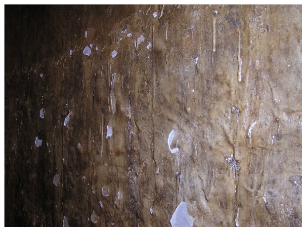
Obrázek 2: Typické oddělování epoxidového nátěru
