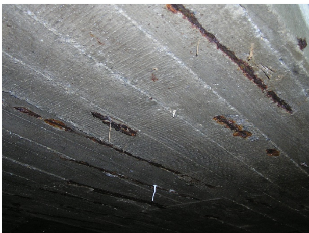
Obrázek 15: Volná korodující výztuž bez krycí vrstvy
