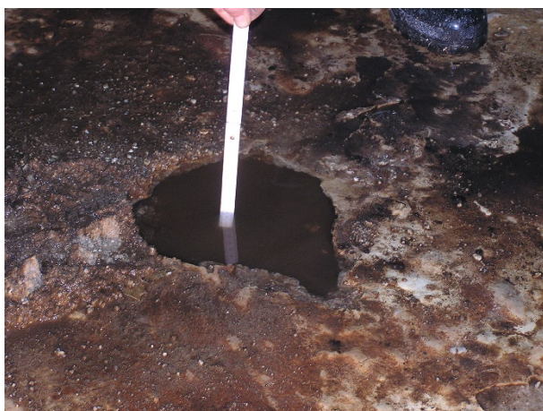
Obrázek 21: Vydrolený spádový beton
