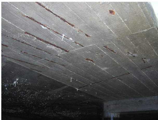
Obrázek 13: Typická koroze radiální výztuže
