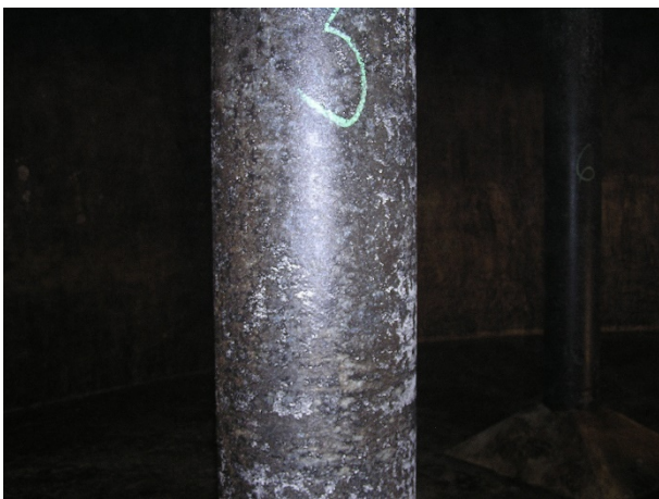
Obrázek 7: Pohled na osinkocementový povrch sloupu
