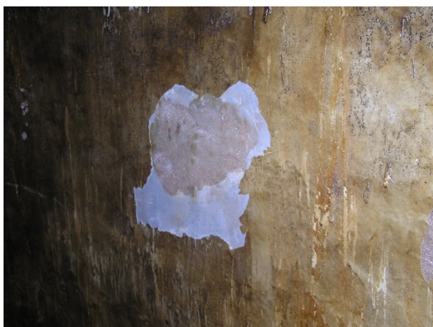
Obrázek 1: Oddělení epoxidového nátěru s patrnými drobnými trhlinami ve stěře
