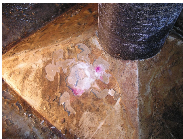
Obrázek 10: Detail oddělujícího se nátěru patky
