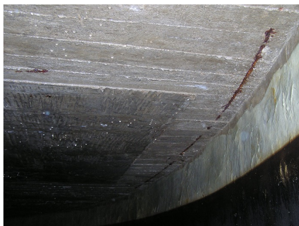
Obrázek 12: Koroze obvodové výztuže
