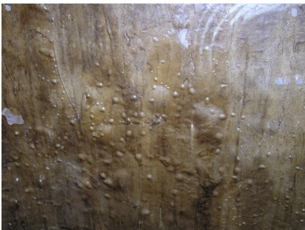
Obrázek 3: Oddělení epoxidového nátěru od podkladu
