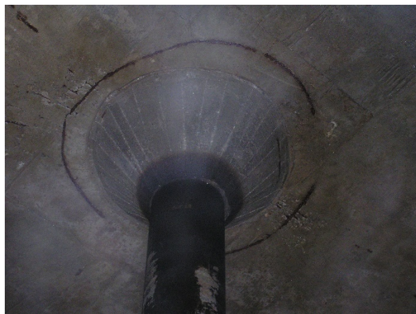
Obrázek 8: Ukončení středového sloupu kónusem
