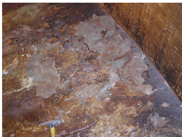
Obrázek 22: Značné oddělení epoxidového nátěru u stěny
