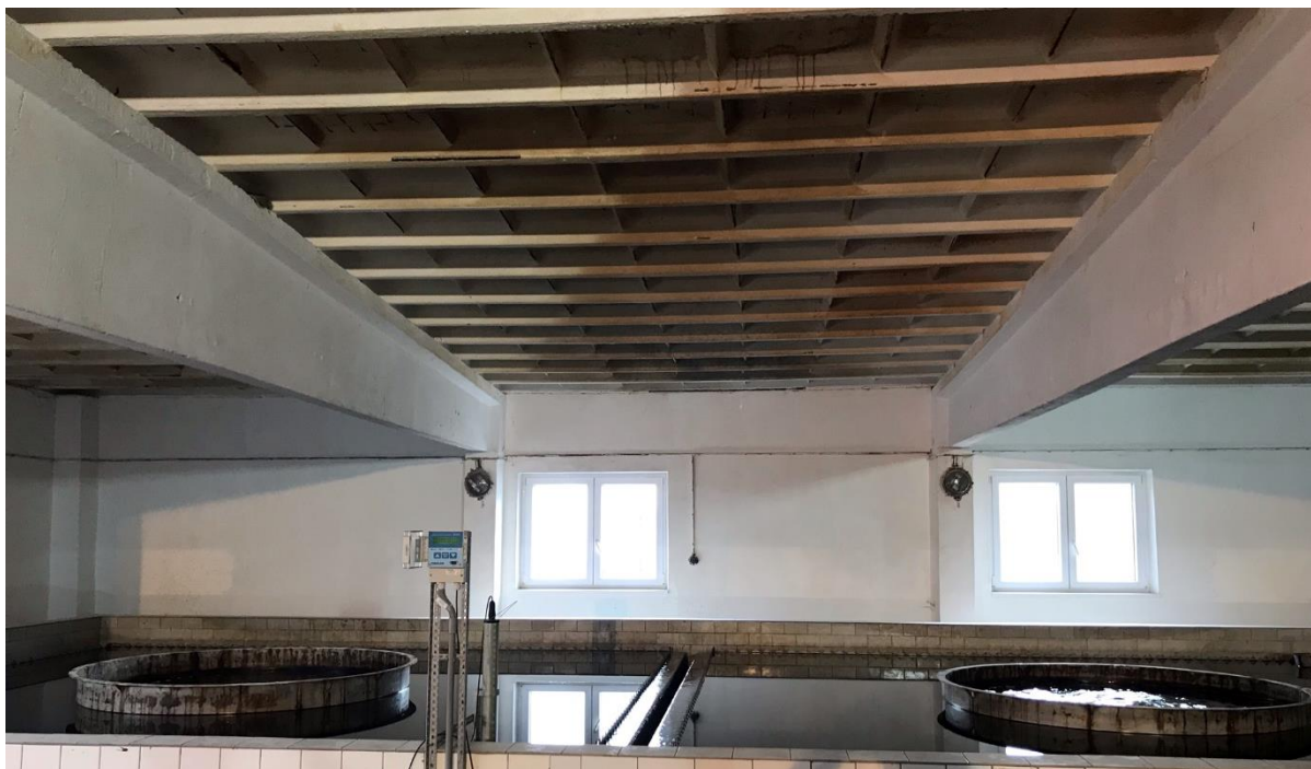
Obrázek 4: Poškozená ŽB stropní konstrukce nad nádržemi s vodou
