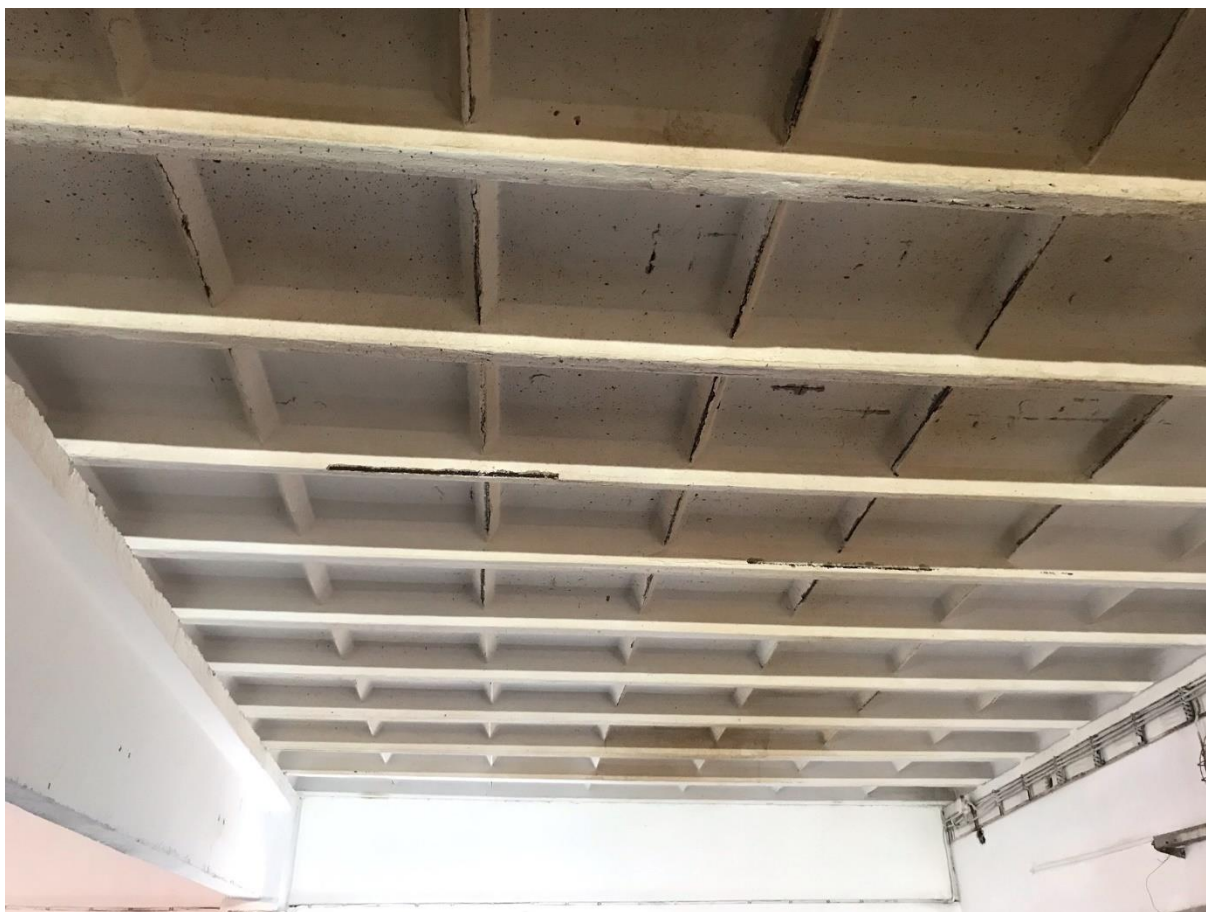
Obrázek 1: Koroze výztuže příčných i podélných žeber
