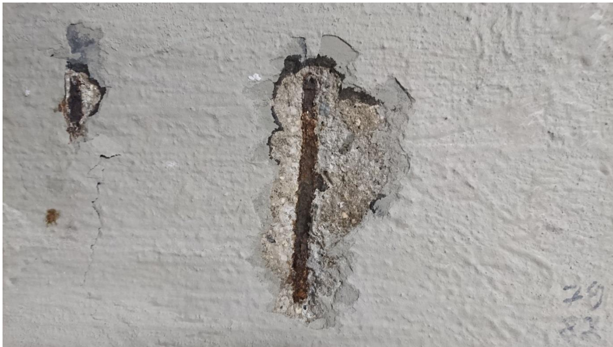
Obrázek 7: Prokreslování zkorodované výztuže, nedostatečná krycí vrstva
