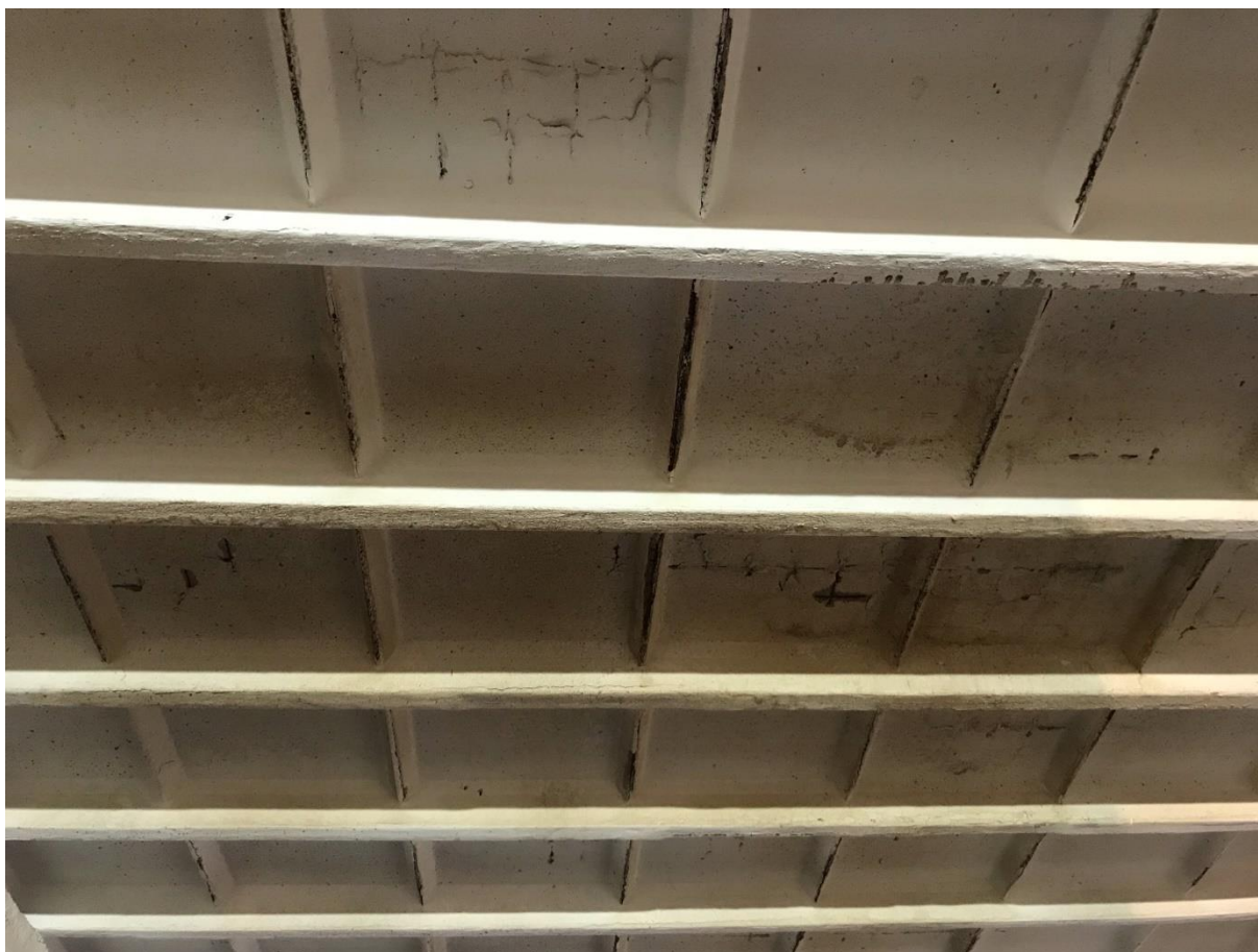
Obrázek 2: Koroze výztuže příčných žebel, koroze výztuže v ploše skořepiny
