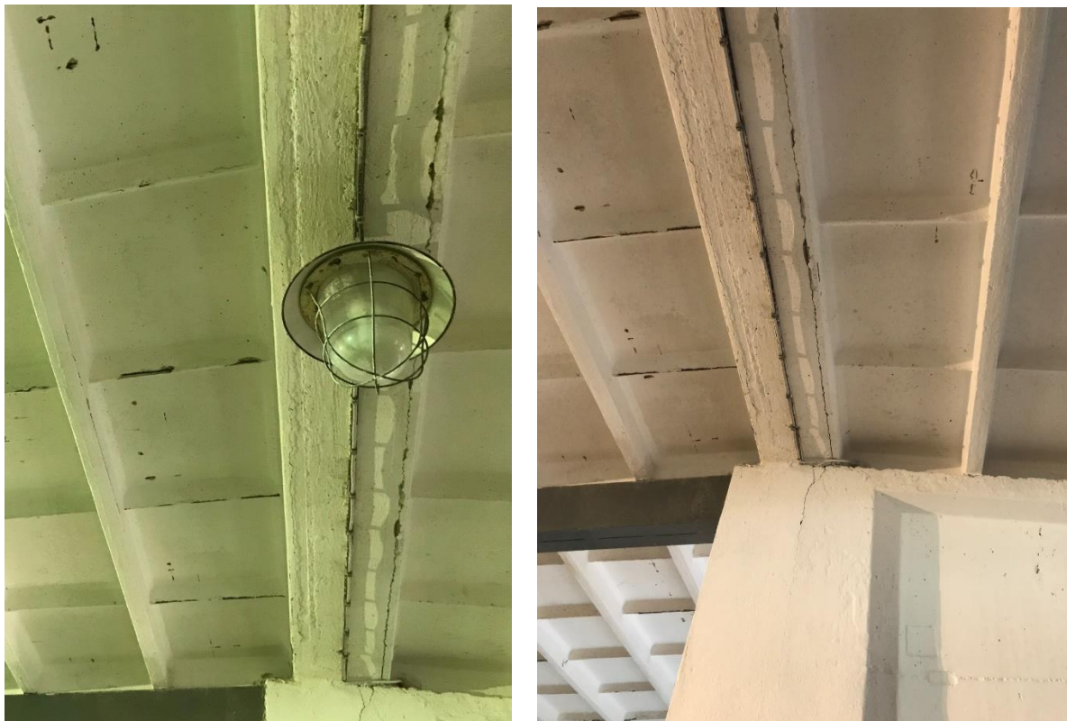
Obrázek 3: Koroze výztuže – středový trám
