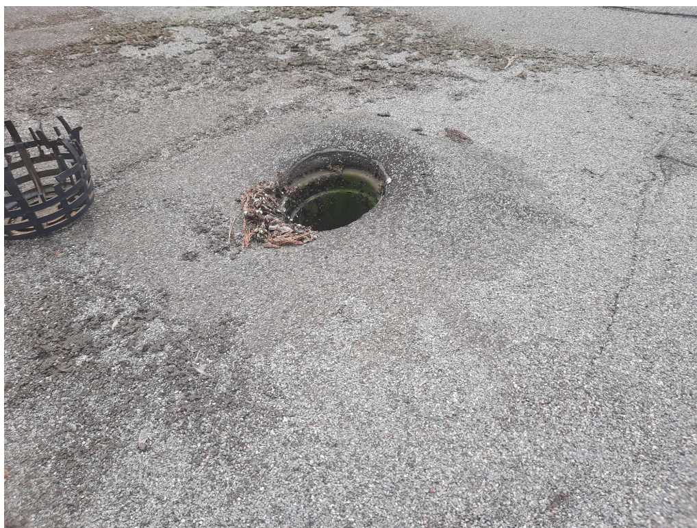
Obr. 3 – pohled na přizvednutou sčršní vpust'
