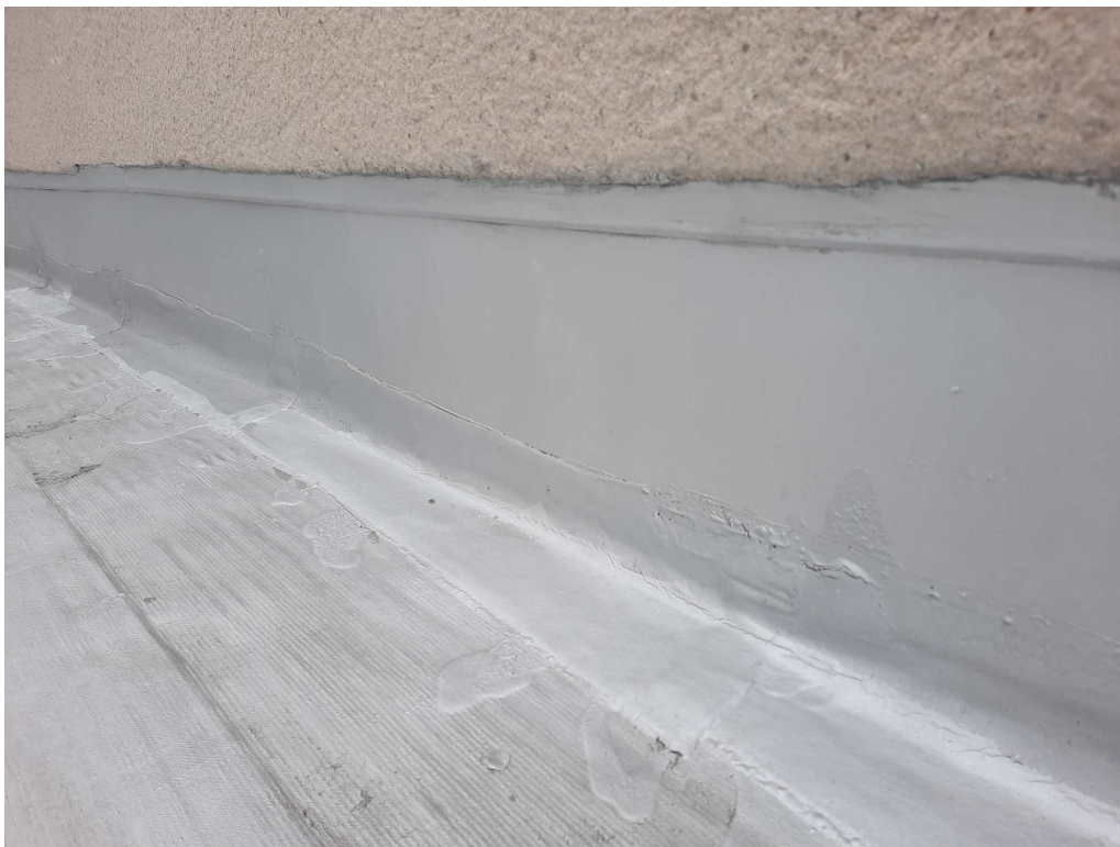
Obr. 4 – detail vytažení hydroizolační vrstvy na stěnu vyšší budovy
