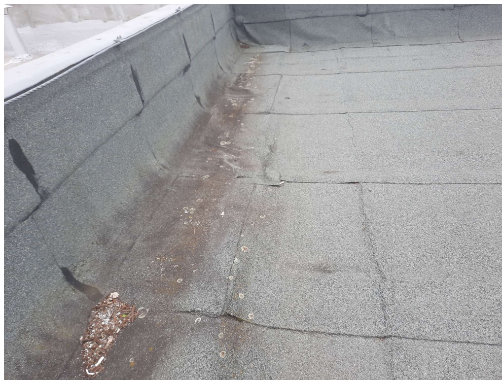
Obr. 2 – detail nerovností v asfaltovém pásu
