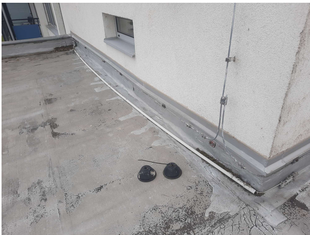
Obr. 2 – pohled na sokl u navazující vyšší budovy A, kde bude provedeno podvléknutí stěnové lišty
